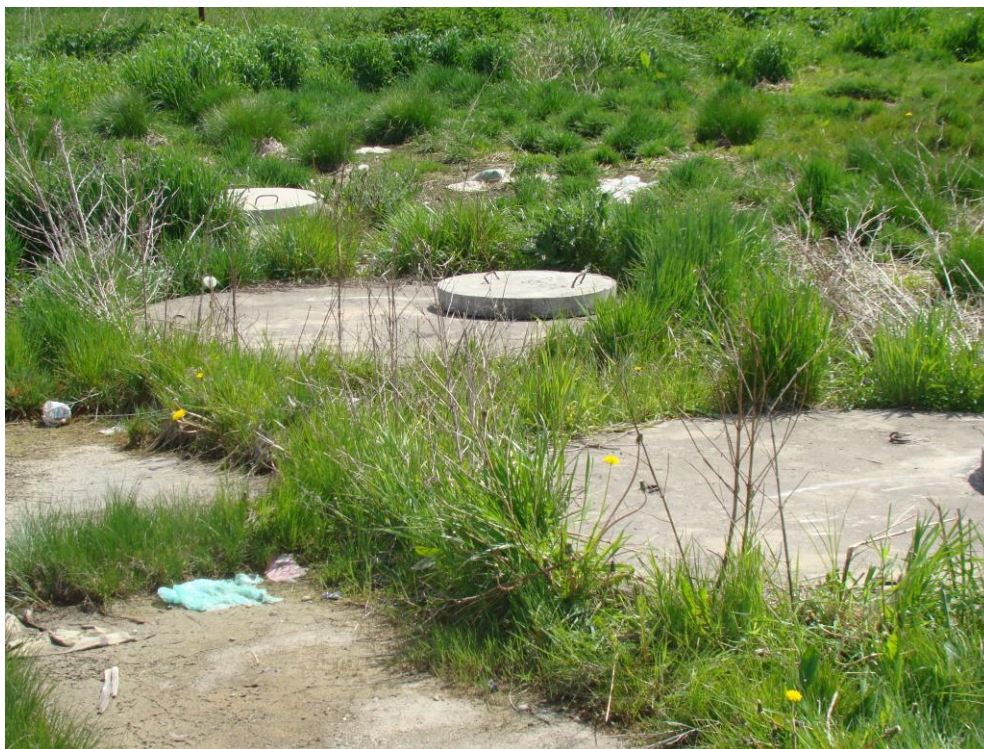
Rysunek 4. Zbiornik na odcieki na składowisku (foto. Jacek Sawicki)
